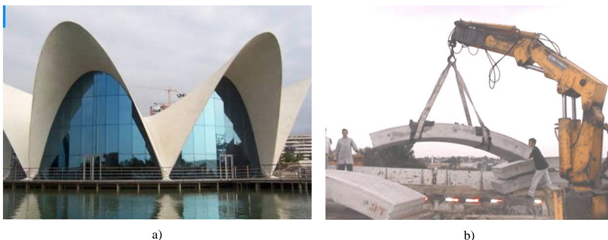
Figura 1.3. Aplicação do concreto reforçado com fibras de aço (a) Oceanográfico de Valência na Espanha (b) Aduelas de concreto reforçado com fibras de aço utilizadas em túneis.
