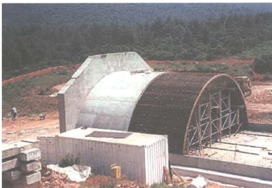
Figura 1.2. Estrutura em forma de “iglu”, concretada com CAA
