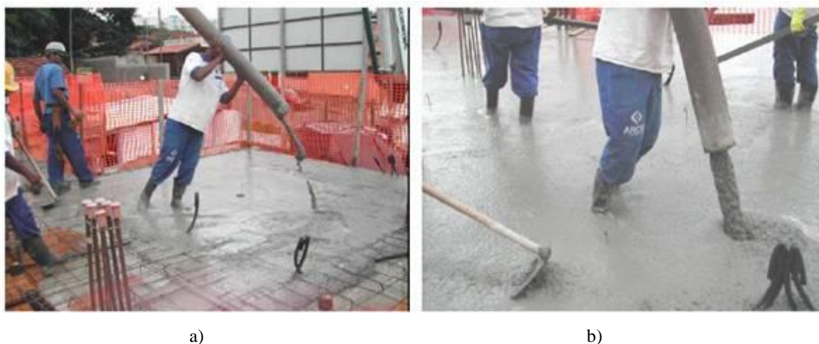
Figura 1.1. Lançamento do concreto autoadensável (a) concreto se adensando com seu peso próprio (b) facilidade no espalhamento e adensamento do concreto autoadensável
