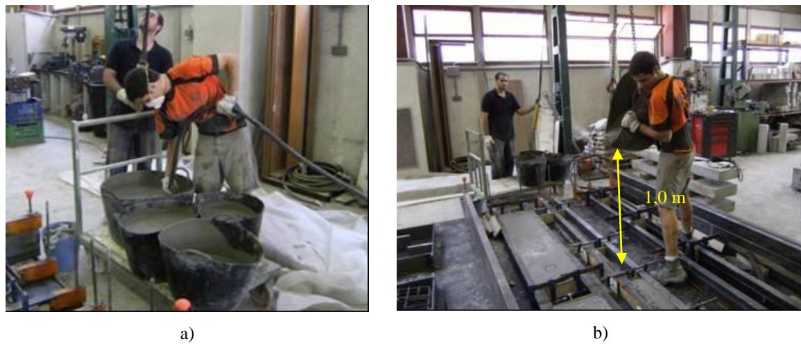
Figura 3.13. (a) CAA sendo agitado antes do lançamento (b) concreto sendo lançado na fôrma.
