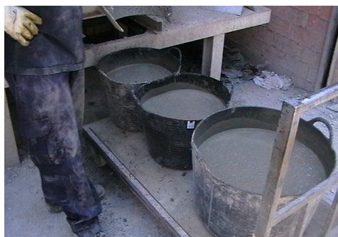
Figura 3.11. Transporte do CAA e do CAARFA para o local de concretagem.
